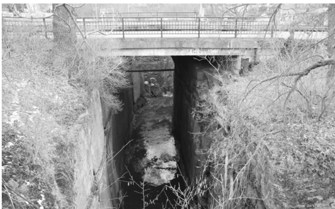
Fig. 12. Bridge over the Novozámecký gap in the village of Zahrádky (source: VMG archive).
