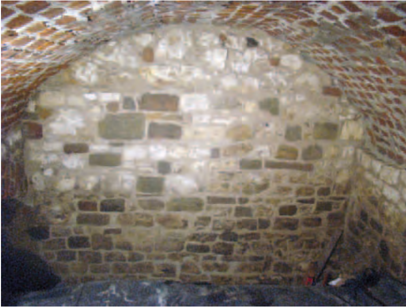
Fig. 3. Kraków, the Main Market Square, St Mary's Church. The remains of the stone wall in the Renaissance crypt under the south tower. The wall was built of recycled materials from the demolition of the Romanesque church. View from N. Photo: E. Zaitz Ryc. 3. Kraków, Rynek Główny, kościół Mariacki. Relikty kamiennego muru w renesansowej krypcie grobowej pod wieżą południową. Mur zbudowany był z wtórnie użytych materiałów pozyskanych z rozbiórki kościoła romańskiego. Widok od N. Fot. E. Zaitz
