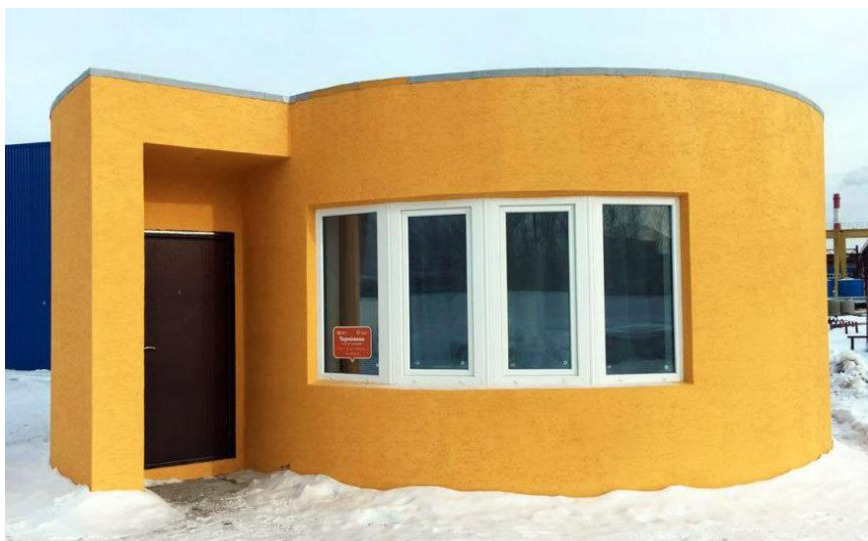
Rys. 2. Dom mieszkalny wydrukowany przez Apis Cor
