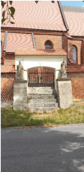
Fot. 2. Widok współczesny dawnego wejścia
