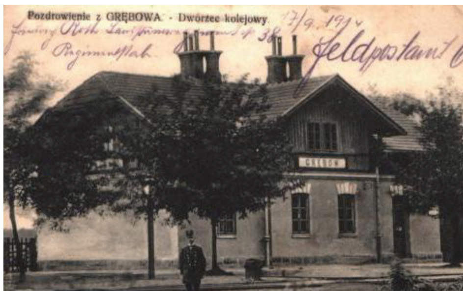
Ryc. 16. Stacja Grębow – stan przed 1915 r.
