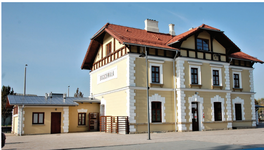
Ryc. 23. Stacja Boguchwała – widok od strony podjazdu
