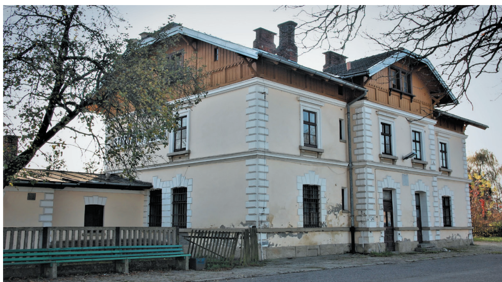
Ryc. 27. Stacja Strzyżów, widok od strony podjazdu – stan z marca 2019 r.
