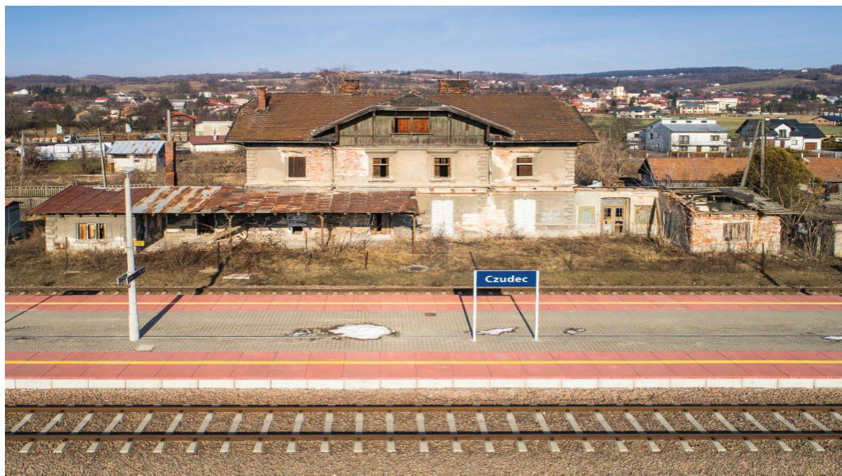
Ryc. 24. Stacja Czudec, widok od strony torów – stan z lutego 2019 r.
