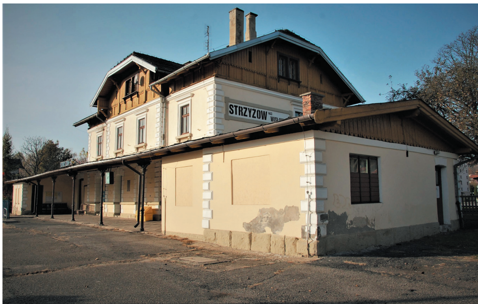
Ryc. 26. Stacja Strzyżów, widok od strony torów – stan z marca 2019 r.
