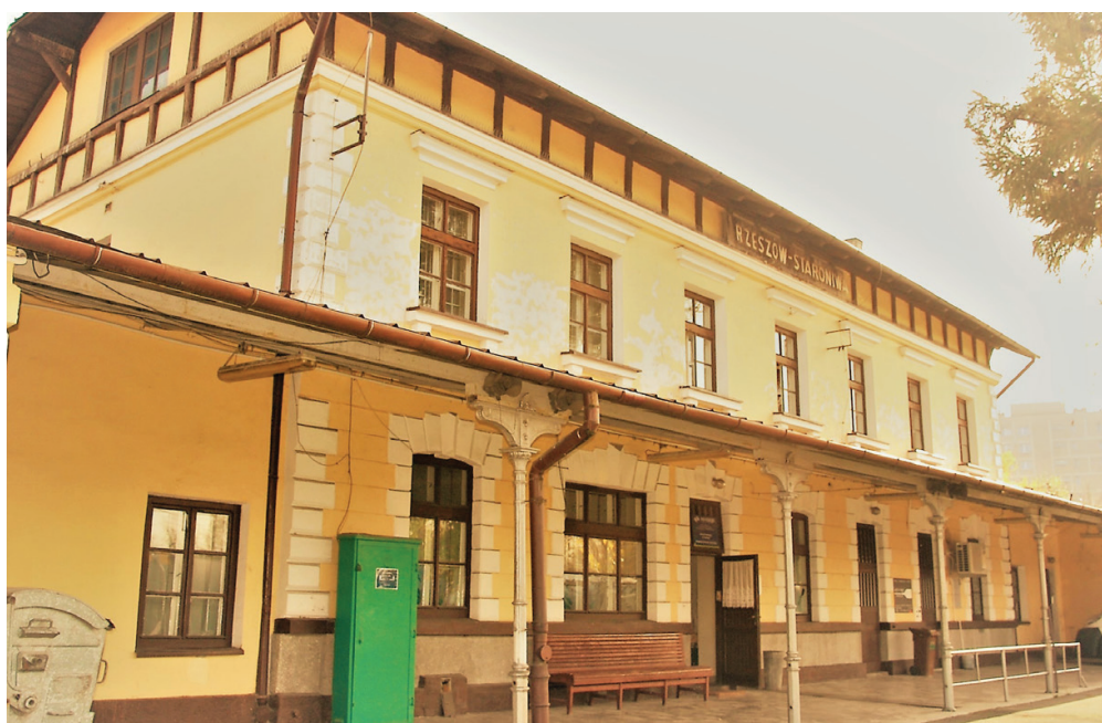
Ryc. 20. Rzeszów Staroniwa, widok od strony torów – stan współczesny
