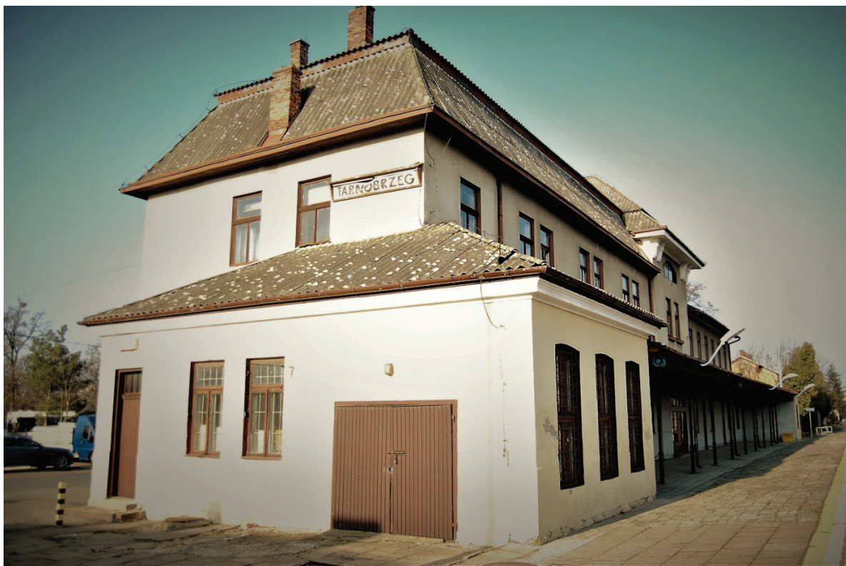
Ryc. 7a. Dworzec kolejowy w Tarnobrzegu, stan zachowania z początku listopada 2018 r.
