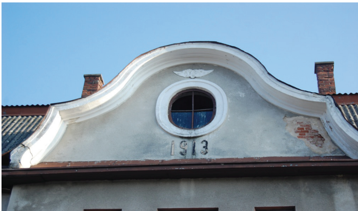
Ryc. 7b. Detal – widoczna data rozbudowy dworca
