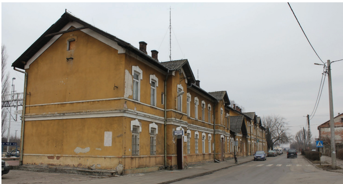
Ryc. 3. Stacja Rozwadów – stan obecny
