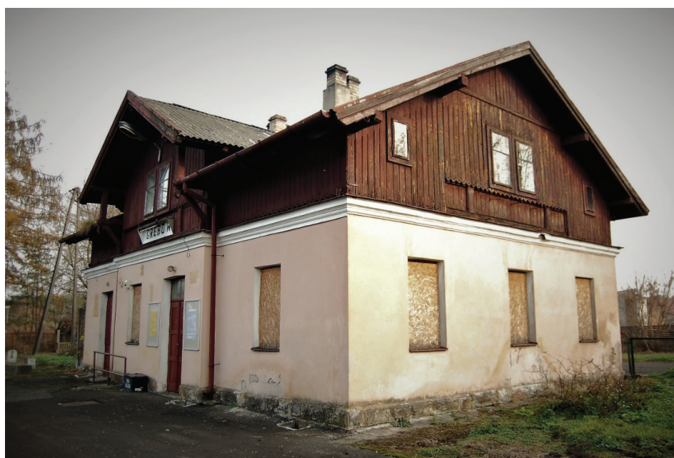
Ryc. 17. Stacja Grębow – stan obecny, listopad 2018 r.
