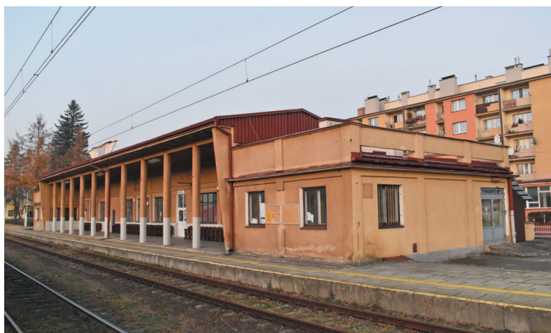
Ryc. 31. Jasło – budynek dworca od strony torów, rok 2018
