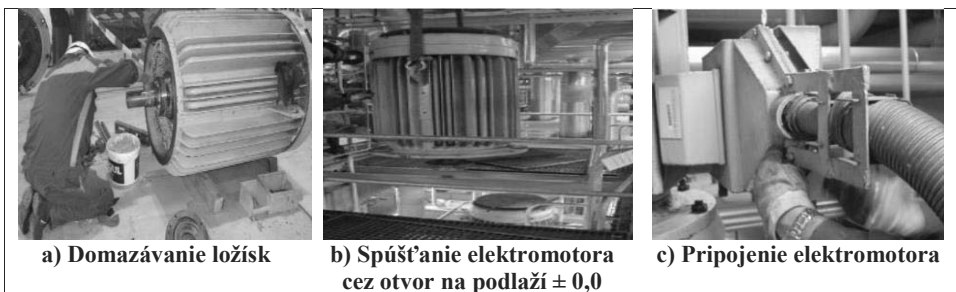
Obrázok 3. Činnosti pri oprave elektromotora [Tinák 2015]
