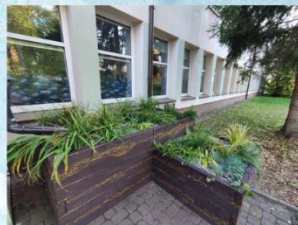
14. Completed work on the rain garden 14. Zakończone prace przy ogrodzie deszczowym
