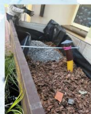
8. PCV pipe filling 8. Zасыpanie rury PCV
