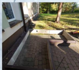
5. Preparing the chest 5. Przygotowanie skrzyni
