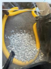
7. Laying PCV pipe in the chest 7. Ułożenie rury PCV w skrzyni
