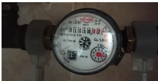
Rys. 1. Wodomierz Metron JS 1,5 41, wykorzystany w badanym gospodarstwie
