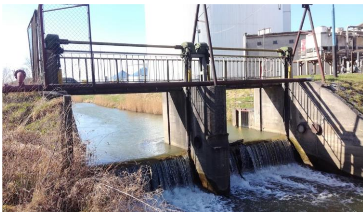
Rys. 2. Jaz z zamknięciami piętrzący wodę na rzece Olawa bez elektrowni wodnej
