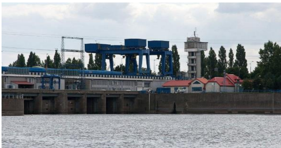
Rys. 1. Przepływowa elektrownia wodna we Włocławku na Wiśle o mocy 160 MW
