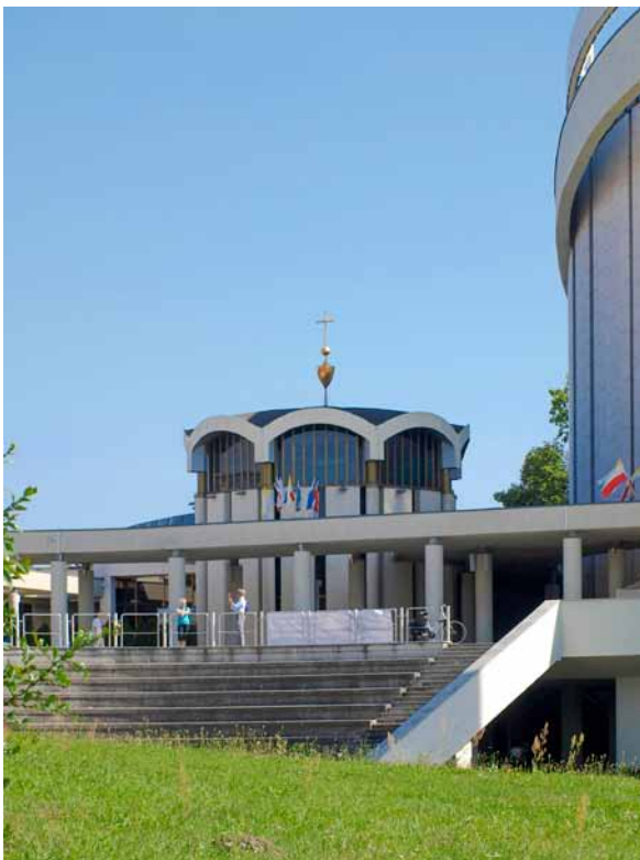
27. Witold Cęckiewicz, kaplica wieczystej adoracji Najświętszego Sakramentu przy sanktuarium Bożego Miłosierdzia , 1997–2002, Łagiewniki (Kraków), fot. J. Turbasa
