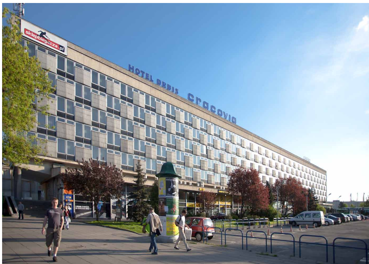
1. Witold Cęckiewicz, Hotel Cracovia , 1959–1965, Kraków, fot. B. Pyrzyk
