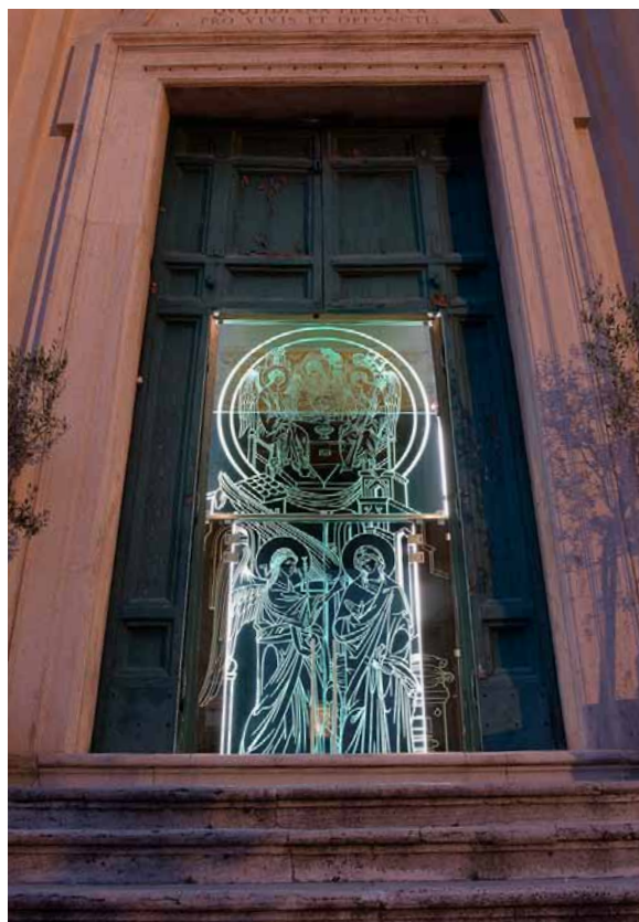
14. Kościół Najświętszego Imienia Maryi na Forum Trajana, Rzym, wejście w elewacji frontowej, fot. według: http://www.greentechno.it/realizzazioni/nuova-bussola-ingresso-chiesa-ss-nome-di-maria-al-foro-traiano/
