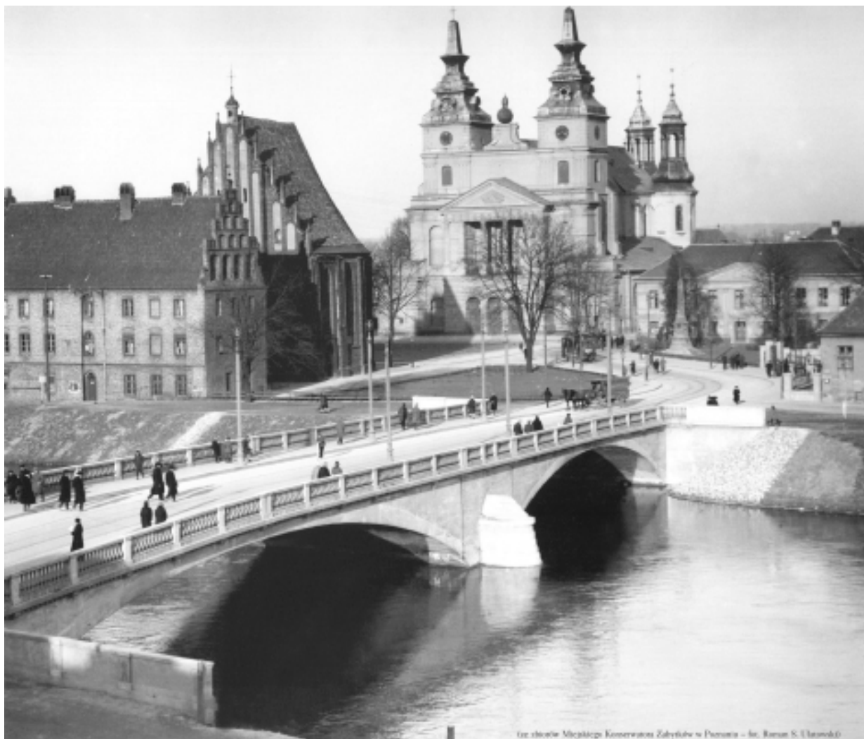
2. Poznań, Most Chrobrego i Ostrów Tumski, lata 30. XX wieku, fot. w zbiorach Archiwum Instytutu Historii Sztuki UAM
