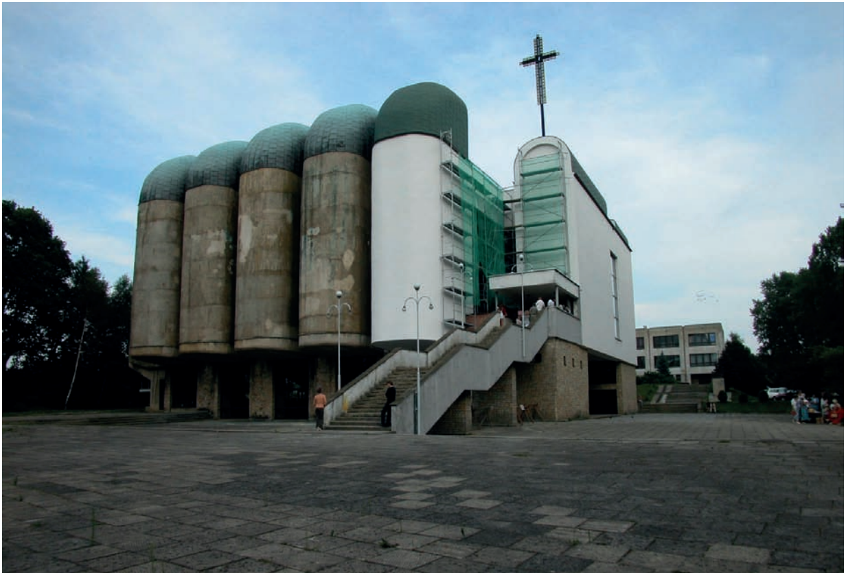
1. Kościół Najświętszej Marii Panny w Jastrzębiu Zdroju, 1976–1980, arch. Mieczysław Król; widok elewacji frontowej. Fot. J. Sowińska
