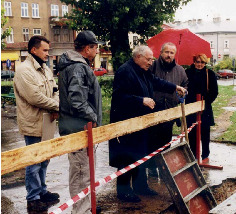
Wylewanie fundamentów pod rzeźbę Przejście 2001 , Rzeszów, 2002 rok. Na zdjęciu od lewej: Marcin Rut – wykonawca rzeźby, N.N., Józef Szajna, Jerzy Fąfara, autor książki 18 znaczy życie. Rzecz o Józefie Szajnie , Helena Maria Grad, pierwszy kustosz Galerii Szajna w Rzeszowie, fot. z archiwum autora
