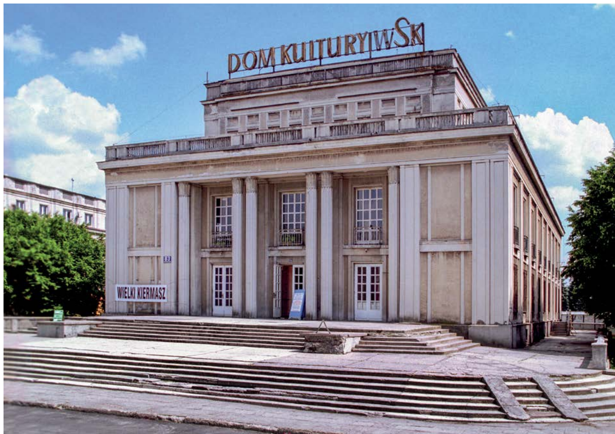
Dom Kultury WSK w Rzeszowie, elewacja frontowa w latach 90. XX wieku, fot. Jacek Stankiewicz
